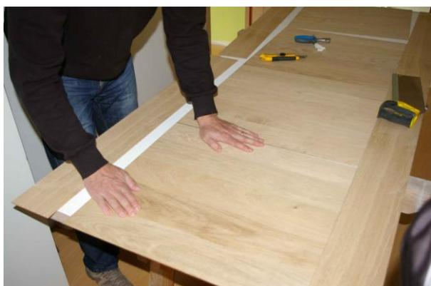
6- Positionner et coller le second panneau (sans bord aminci) (D) en laissant un joint de dilatation avec le 1° de 2 à 3 mm.
